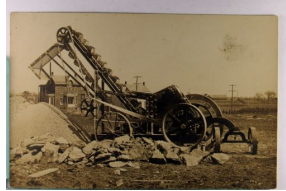
214. Gravel & Stone Sorting Machine, Real Photo w/ AZO P.C. back VF .. $80.00
