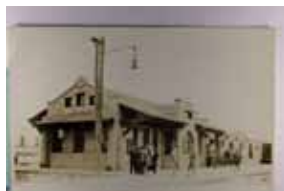
1414. Depot, Las Cruces, New Mexico, Real Photo w/ AZO P.C. back VF .. $60.00
